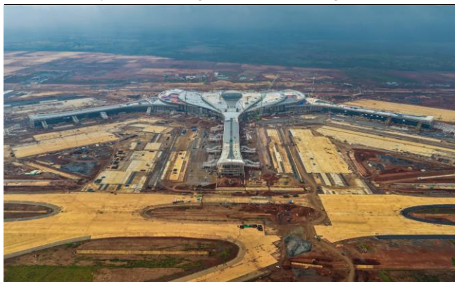
Ảnh 7. Tiến độ sân bay Long Thành (cuối tháng 8/2025)
