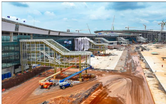
Ảnh 8. Tiến độ sân bay Long Thành (cuối tháng 8/2025)
